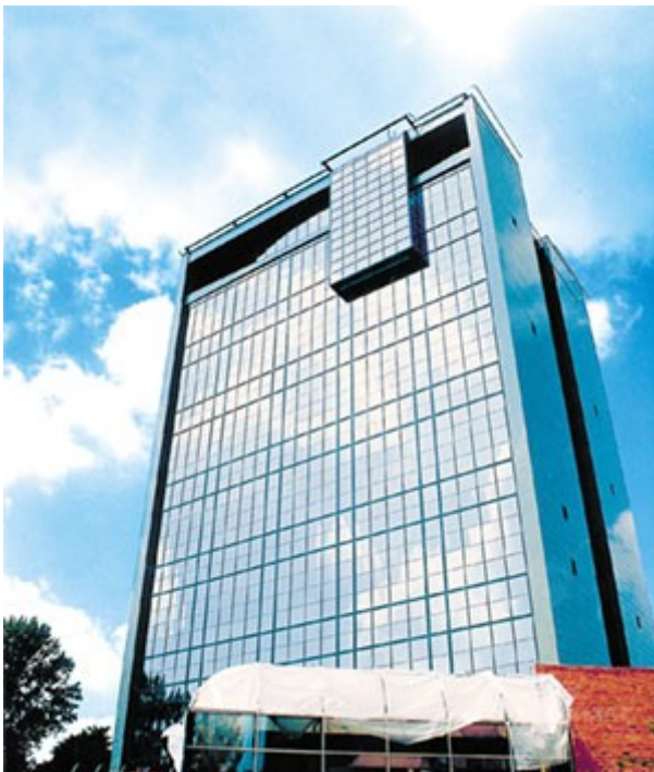
Zastosowanie dybli ramowych Arvex® do mocowania fasady biurowca (Poznań).
